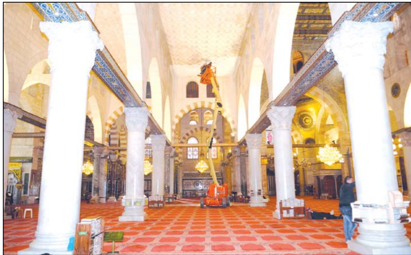
القدس - موظفون من لجنة اعمار الاقصى يقومون باعمال ترميم داخل قبة الصخرة المشرفة وفي الصورة السفلى اعمال صيانة داخل المسجد الاقصى. تصوير: محمود عليان
